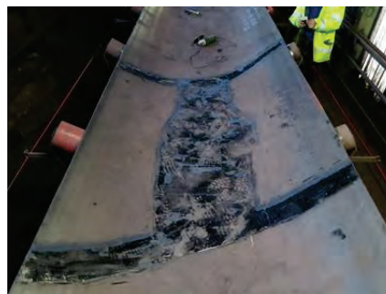
تسمه نقاله معدن پاره شده است تسمه نقاله ترمیم شده با بلزونا 2111. 2311
